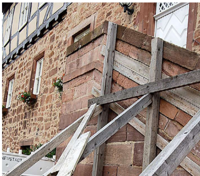
Ein Gerüst aus Holzbalken stützt die Treppe des Neustädter Rathauses. Foto: Michael Rinde
